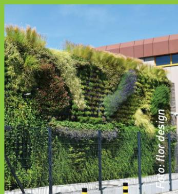
▷ Das System am GreenCityTower besteht auf der Ansichtseite aus einer weiß lackierten, gelochten, Metallplatte, die die Hochbauarchitekten auch an den unbegrünten Fassadenflächen vorgesehen haben. Die Ständerkonstruktion besteht zu 70% aus recyceltem Alu-Material und kann im Falle eines Rückbaus rückstandsfrei gelöst werden und wieder verwendet werden. Das Substrat und die Pflanzen sind ohnehin kompostierbar.
