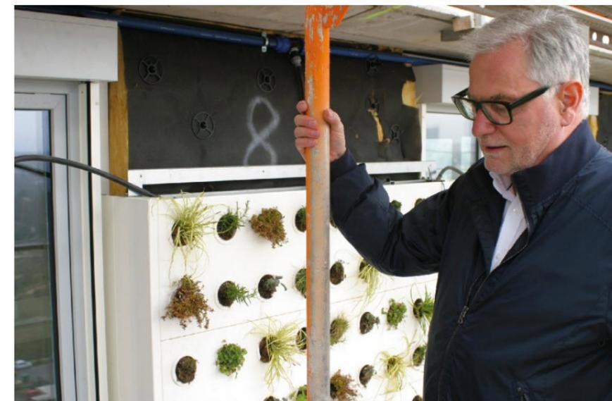
Klaus Wegenast erklärt den Aufbau aus Fassadenblech, Substrat und Pflanzen, dahinter sitzt die Dämmung und das digital gesteuerte Bewässerungssystem.
