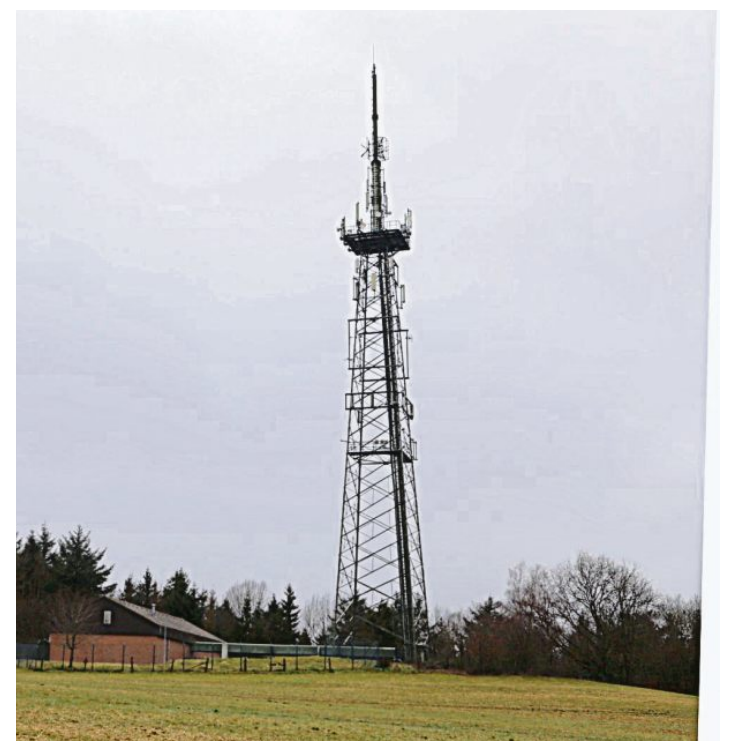
Ein 30 Meter hoher Gittermast wie dieser sollte zwischen zwei Wohnhäusern in Holzmülheim gebaut werden. Foto: Stephan Everling
