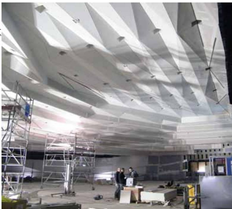
**Rauten.** Die Stahlunterkonstruktion des Saals wurde an den Deckenflächen mit speziell gefalteten, dreieckigen Paneelen auf Gipsfaserbasis verkleidet.
