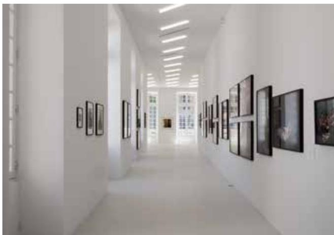
*Abb.: Die in den Ausstellungsflächen durchgängigen, diagonalen Raster aus linearen LED-Halbeinbauleuchten sorgen optisch für einen Zusammenhalt aller Gebäude des Ensembles.*
