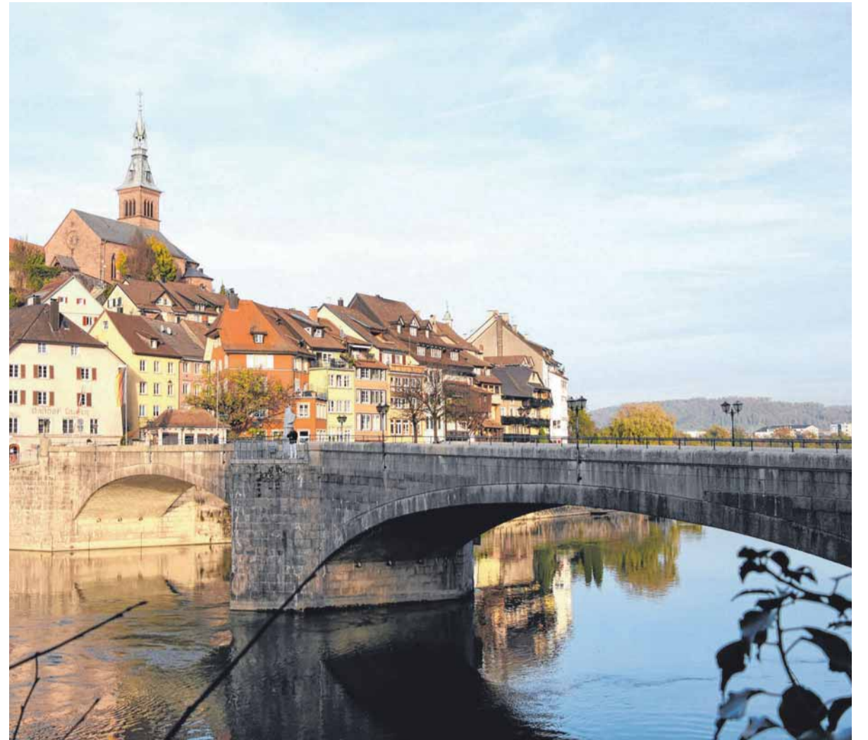
In Laufenburg führt eine Brücke vom deutschen in den Schweizer Teil der Stadt.
