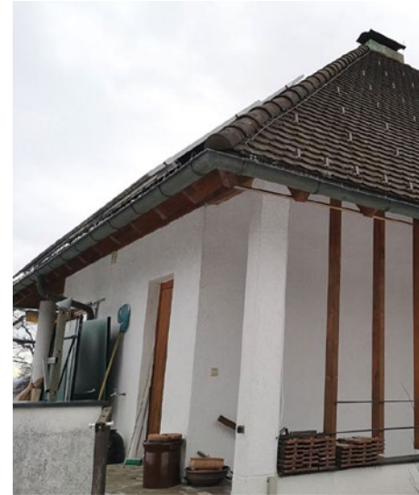
Vor der Verdichtung war das Einfamilienhaus eingeschossig und in die Jahre gekommen.
