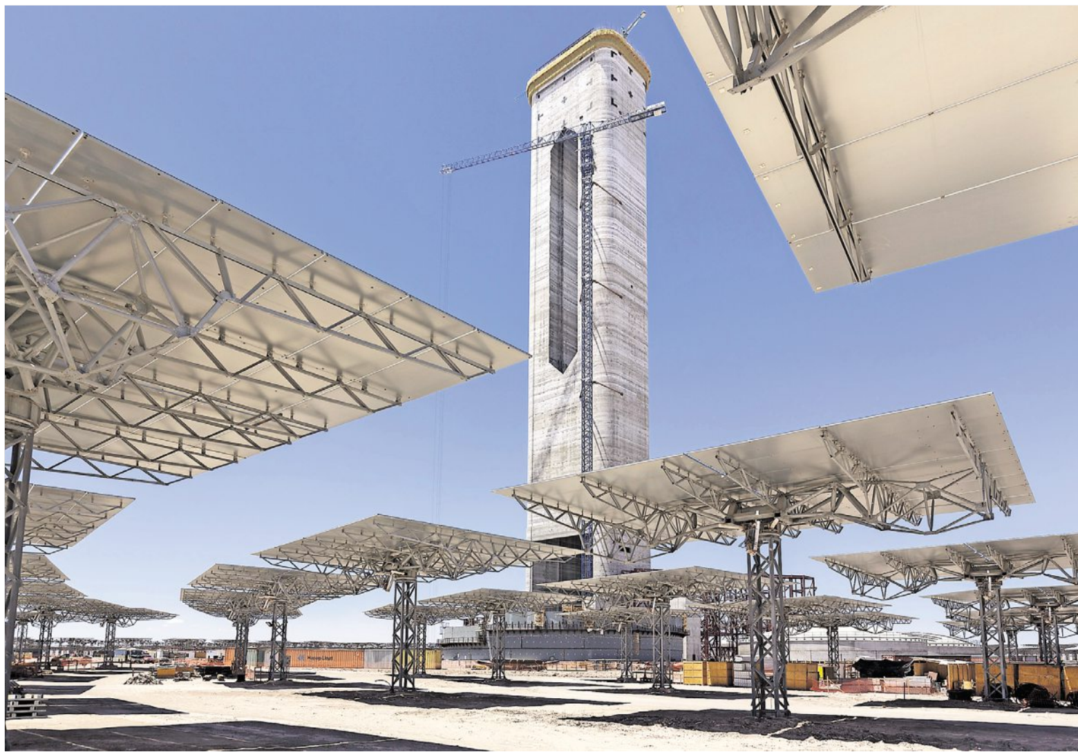
Derzeit stehen die Kräne still, doch bald schon soll an der gigantischen Solarenergie-Anlage in Chiles Atacama-Wüste weitergebaut werden: 210 Meter hoch ist der Turm, auf dessen Spitze dann 10.600 jeweils 144 Quadratmeter große Spiegel die Energie der Sonne fokussieren sollen.
