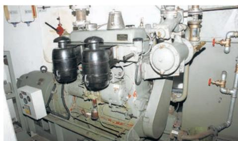
Dieser Vier-Zylinder-Dieselmotor (90 PS) sollte den Bunker mit Notstrom versorgen
