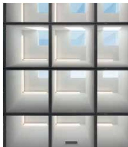
**Berechneter Lichteinfall.** Damit kein direktes Sonnenlicht auf die Ausstellungsflächen trifft, definierten die Lichtplaner von Reflexion in digitalen Simulationen sowohl die Dimension als auch den Winkel der im Ergebnis azentrischen Öffnungen des gerasterten Tageslichtsystems.
