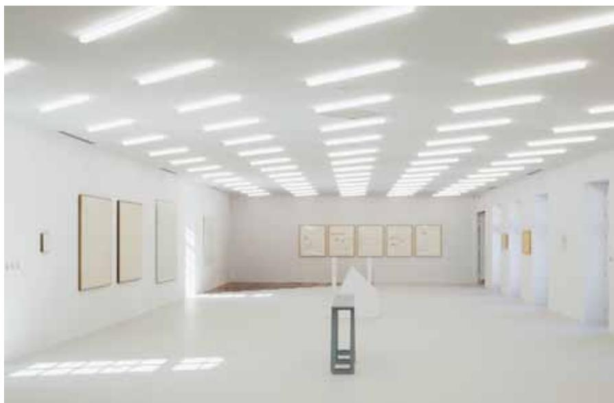
**Zusammenhang.** Die Lichtplaner ließen exakt berechnete Aussparungen in den Gipskartondecken vornehmen, welche die Technik verbergen und ausschließlich die leuchtenden Körper sichtbar machen. Mit diesem Kunstgriff erscheint die Decke wie eine zusammenhängende Leuchtfläche.
