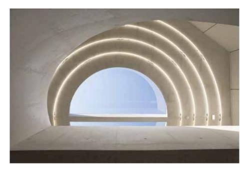
Abb.: Ein vier Meter messender Oculus in der Dachkonstruktion versorgt das neue Atrium, das die beiden Bestandsbauten über alle Geschossebenen verbindet, mit Tageslicht.
