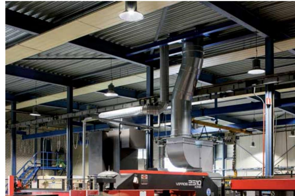
◀ An klassischen Industrie-arbeitsplätzen, an denen das Licht aus größeren Höhen kommt, werden Hallen-tiefstrahler von Lobsled eingesetzt, die effizienter und langlebiger als die herkömmliche Lichttechnik sind.
