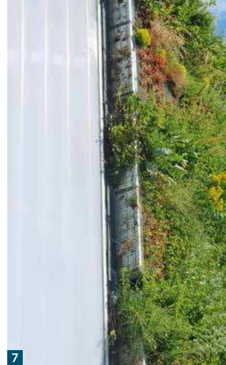
eine intensive Wässerung. Die bepflanzten Körbe sind in Doppelreihen an die integrierten Schienen der Betonscheiben gehängt. Die Anker dafür sind statisch auf das Gewicht des Erdvolumens samt Pflanzenmasse mit Gehölzen bis zu einer Höhe von 300 cm gerechnet. Damit entfällt die Berechnung des sonst notwendigen Einzelnachweises, was wiederum Kosten einspart. Die anfallenden Lasten werden in den Stahlbetonwandscheiben abgetragen, es findet keine zusätzliche statische Belastung des Gebäudes statt.
