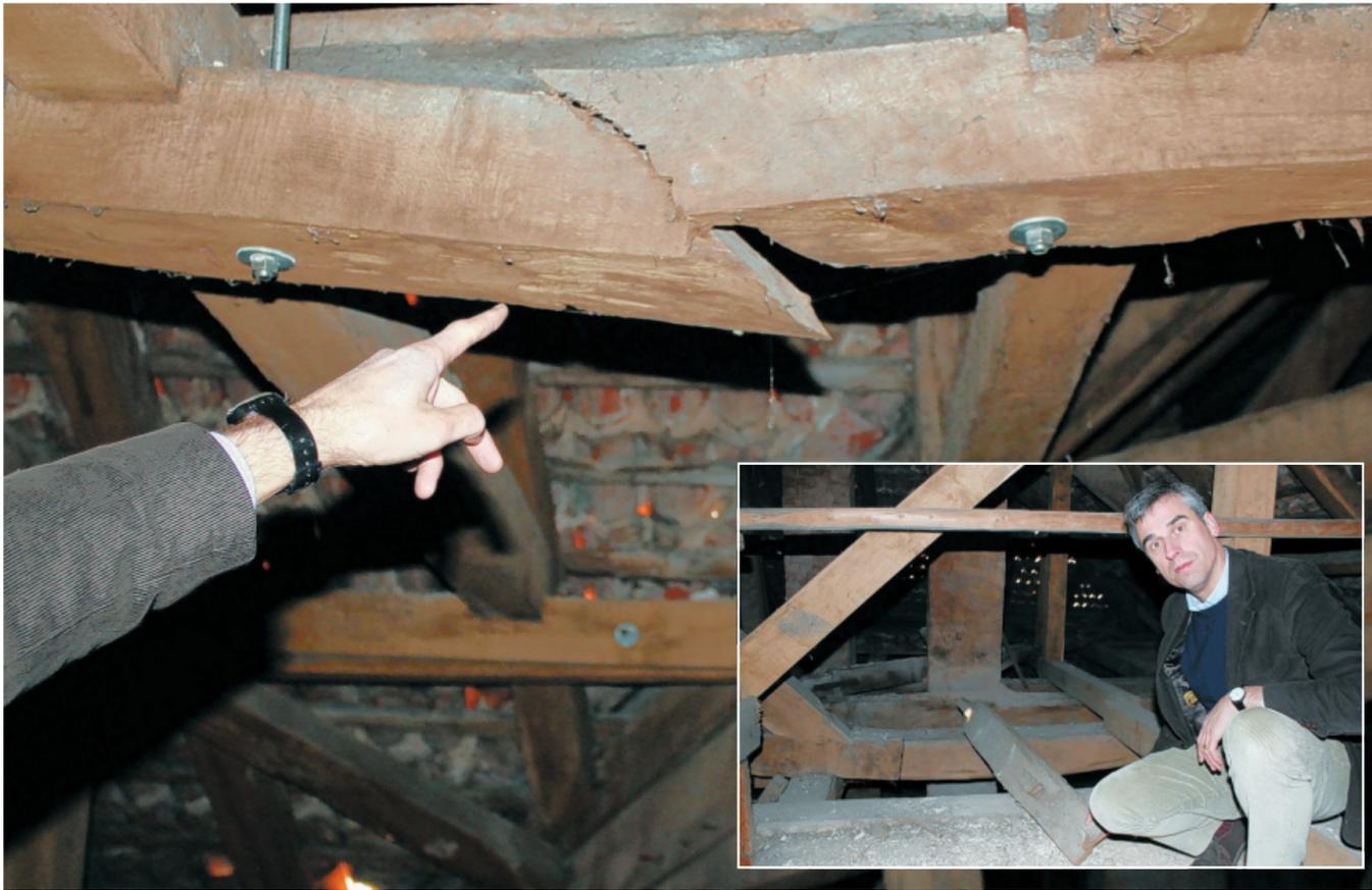
**Risse im Gebälk:** Konstantin Freiherr von Wrede deutet auf einen Riss in einem der massiven Holzbalken. So wie hier sieht es an vielen Stellen des Nordflügels aus. Ein Balkenstück ist sogar schon herausgebrochen (kleines Foto). Neue Stützen verhindern, dass das schwere Dach auf die Grundmauern drückt. Das reicht jedoch nicht aus. FOTOS: JESSICA KLEINEHELFTEWES
