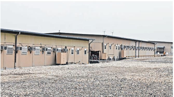
Die Schlafcontainer im Camp sind mit Stahlplatten verkleidet. Unter dem Dach sind Sandsäcke gestapelt, die Beschüssen standhalten sollen.
