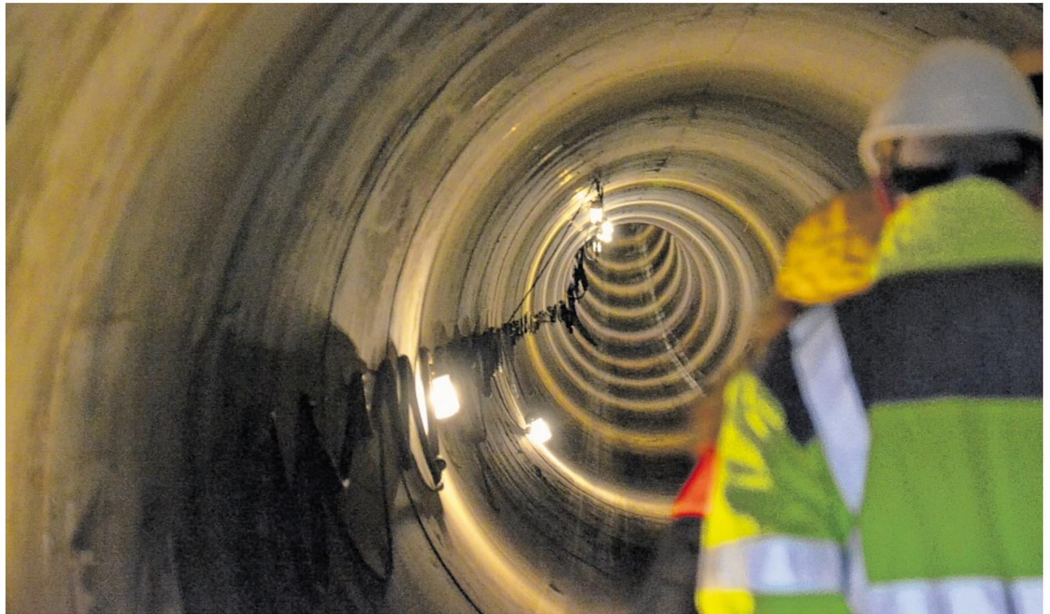
Spaziergang unter der Elbe: Der Tunnel für die neue Gasleitung zwischen Hetlingen und der Insel Lühesand ist etwa 1500 Meter lang.
