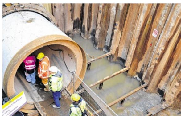
Der Eingang zum Düker liegt mehrere Meter tief. Spundwände stabilisieren die Grube.
