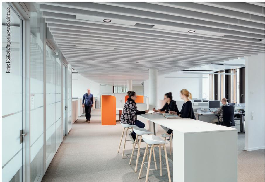
Die Büros sind zu den Fluren hin durch Glastrennwände abgetrennt. Im Open Space wurden weitere Arbeitszonen durch GK-Stummelwände vom Verkehrsweg abgetrennt. Über diesen Arbeitsplätzen wie in den Büros sorgen abgehängte Kühldeckensegel zusätzlich für eine schnelle Anpassung des Raumklimas.
