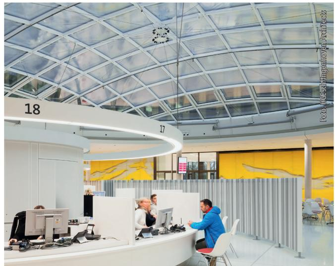
In der Ringleuchte verbirgt sich ein mehrschichtiger Leuchtaufbau. Die LED-Punkte werden von einer mikroprismatischen Abdeckung geschirmt. Mikroperforierte Folien an den Glasscheiben der Kuppel dagegen halten den Nachhall in Grenzen.
