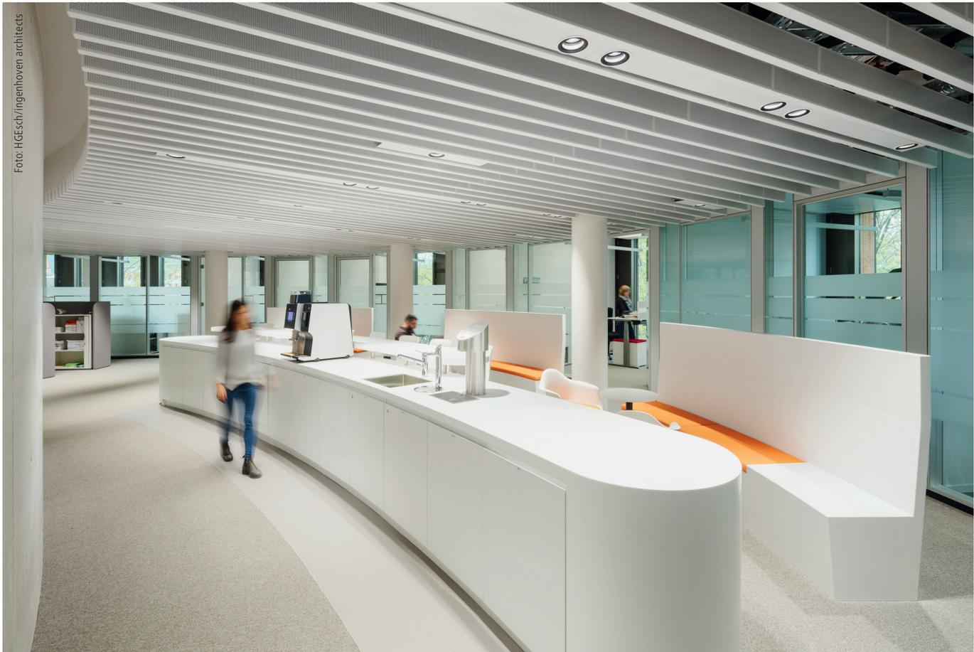
In den Mittelzonen der oberen Büroetagen gelang den Deckenbauern ein Bravourstück. Die einzelnen Metalllamellen folgen mit ihren austarierten Abständen exakt der gerundeten Form des Gebäudes und zeigen selbst in engen Radien eine optische Parallelität.
