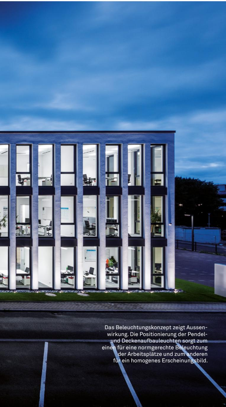
Das Beleuchtungskonzept zeigt Aussenwirkung. Die Positionierung der Pendel- und Deckenaufbauleuchten sorgt zum einen für eine normgerechte Beleuchtung der Arbeitsplätze und zum anderen für ein homogenes Erscheinungsbild.
