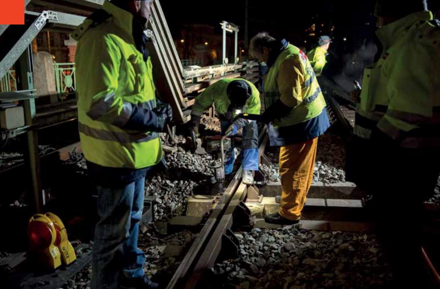
Um die Anhebung der Brücke möglich zu machen, müssen Mitarbeiter der Wiener Linien die oberhalb verlaufenden Schienen mit einem Schlagschrauber aus ihren Befestigungen lösen. Daraufhin setzen die Kollegen unterhalb einen Hydraulikstempel an.
