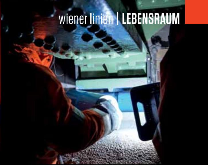
Die Rollen der beweglichen Lager befreien Mitarbeiter der beauftragten Stahlbaufirma mit Schleifgeräten von Roststellen.
