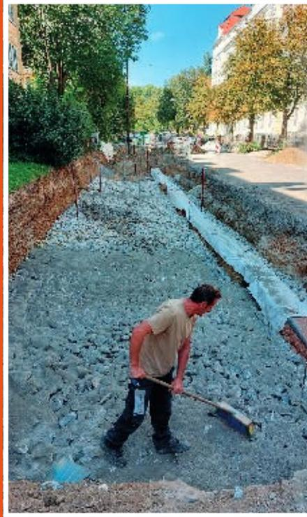
**Zur Nährstoffversorgung der Bäume wird Kompost-Pflanzenkohle-Gemisch gleichmäßig verteilt und mit Wasserdruck in den Schotter eingewaschen.**
