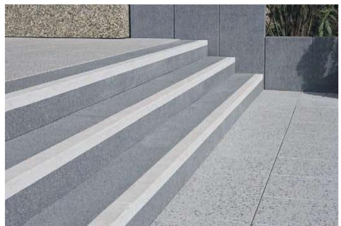
Eine in die Betonstufe eingearbeitete Markierung bietet eine dauerhafte Sicherheit und läuft sich nicht mit der Zeit ab. Foto: Rinn Beton- und Naturstein GmbH
