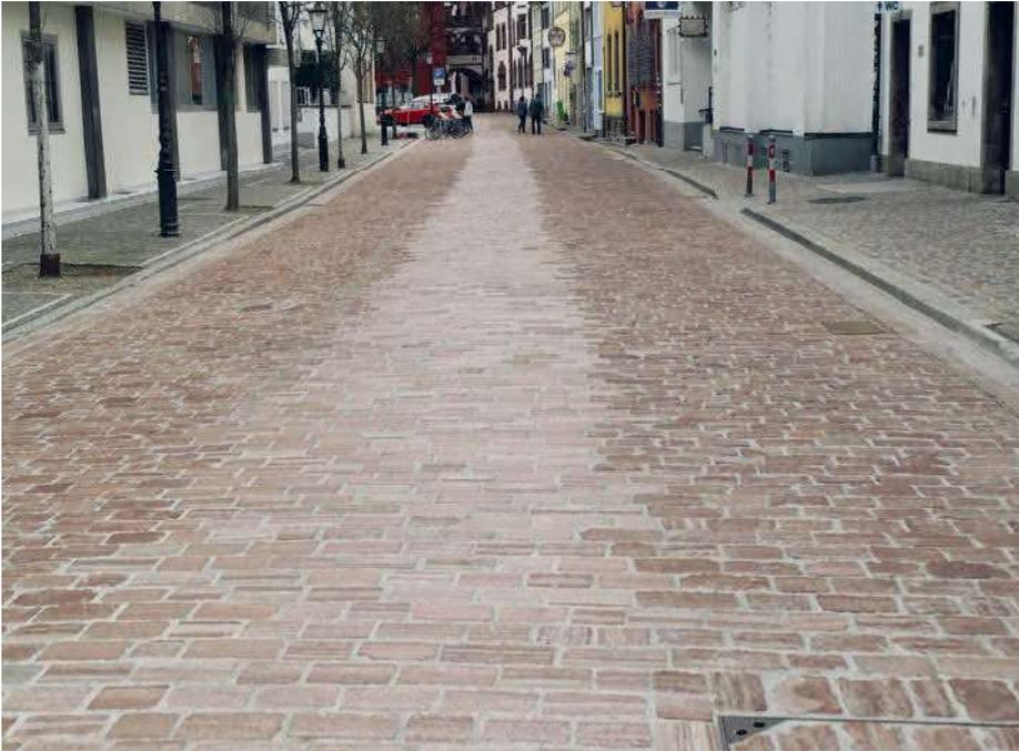
**Das abgeschliffene Altstadtpflaster im Mittelbereich erleichtert die Begehung und gibt auch mit dem Langstock eine tastbare Orientierung.**
