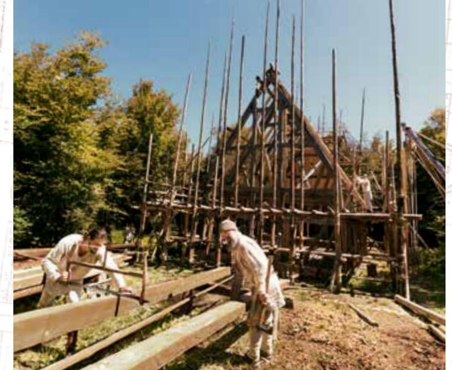
Zuerst wird eine Holzkirche errichtet: sechs Meter breit, zwölf Meter lang und zehn Meter hoch. Wie zu Zeiten Karls des Großen wird für die Gesamtanlage mit der steinernen Klosterkirche mit bis zu 80 Jahren Bauzeit gerechnet
